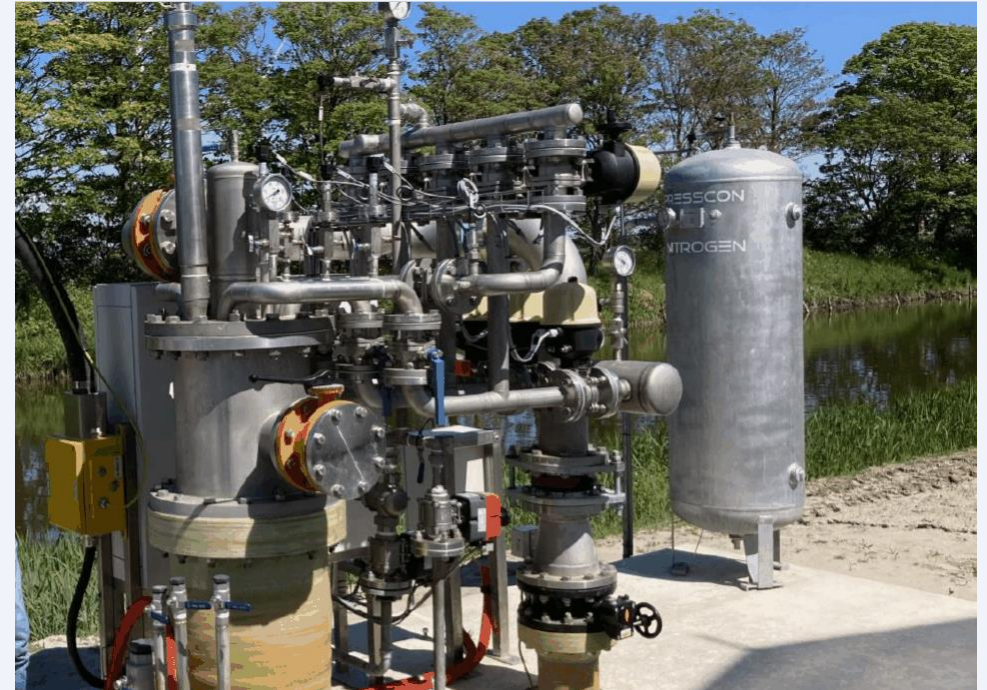
Pompinstallatie voor de HT-ATES demo in Middenmeer (bron: IF Technology)
