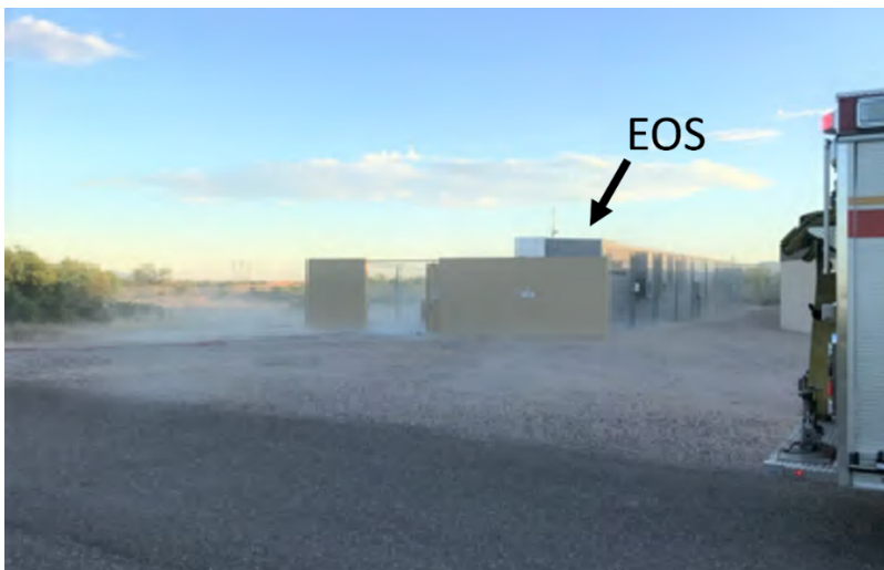
Figuur 6 EOS in Surprise, Arizona tijdens het vrijkomen van gassen gedurende de thermal runaway (McKinnon et al. 2020)
