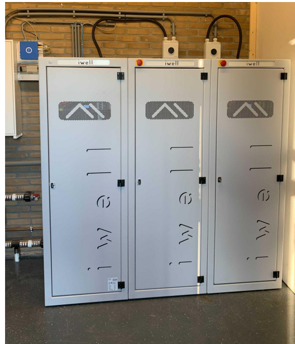
Power Cube o.a. voor flats die overstappen op elektrisch koken én voor het laden van elektrische auto's
